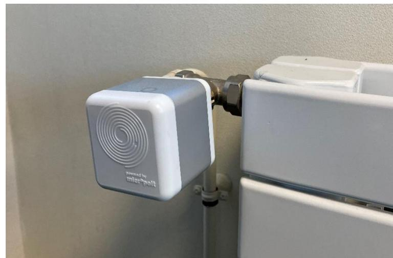
Un des capteurs multiparamètres qui réduit le chauffage dès qu'il détecte une absence prolongée dans la pièce.
