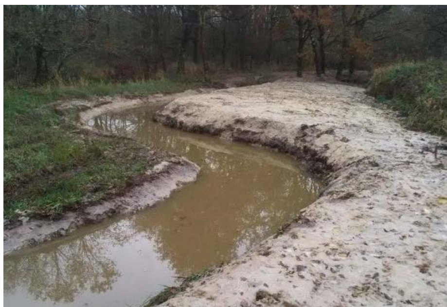
Réouverture du bras de contournement de l'étang par reméandrage afin de diversifier les écoulements.
