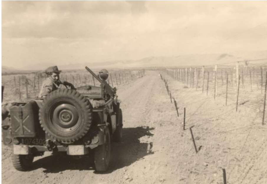
Figure 6 : Surveillance de la barrière électrifiée entre l'Algérie et le Maroc au Pont de Mekter, près Aïn-Sefra, 1960, collection particulière
